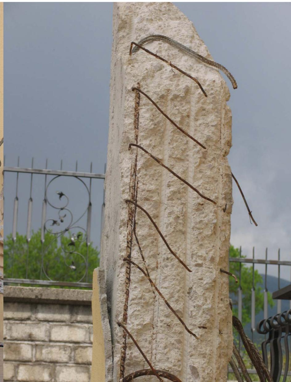
**Le staffe non presentano uncini terminali risvoltati all'interno della massa di calcestruzzo e le legature sono disposte sul medesimo spigolo del pilastro. Ciò ha determinato la mancanza di tenuta di tutta l'armatura longitudinale**
