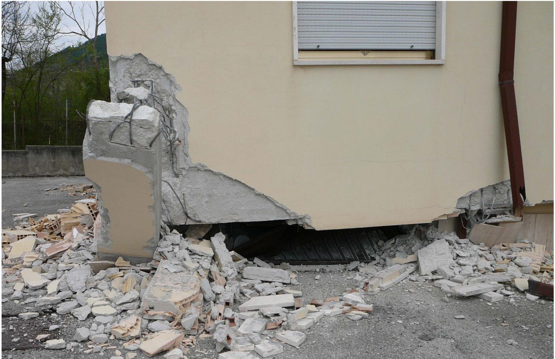
**Sono state rilevate sistematiche carenze costruttive specialmente per quanto riguarda la posa in opera delle staffe nei pilastri, il confinamento dei nodi e la sovrapposizione di armature tra un piano e l'altro.** F. Ortolani – S. Pagliuca – A. Spizuoco
