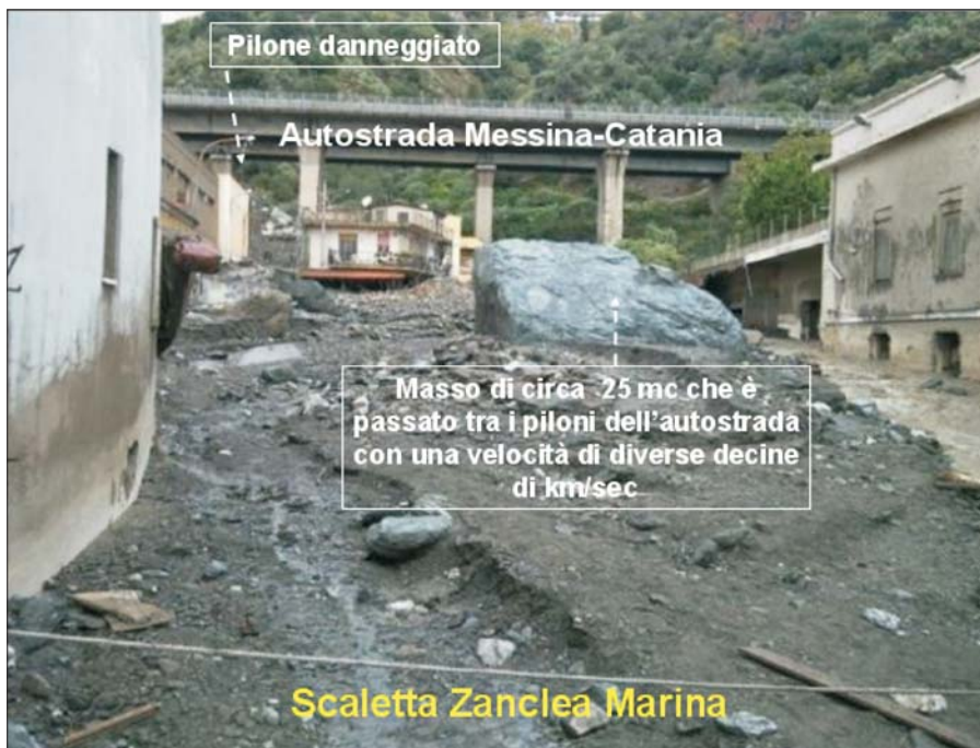
Figura 10 – Massi di roccia di grandi dimensioni, inglobati nella colata fangoso-detrica, che hanno colpito o sfiorato i piloni dell'autostrada. Il masso di maggiori dimensioni è di circa 25 mc.
