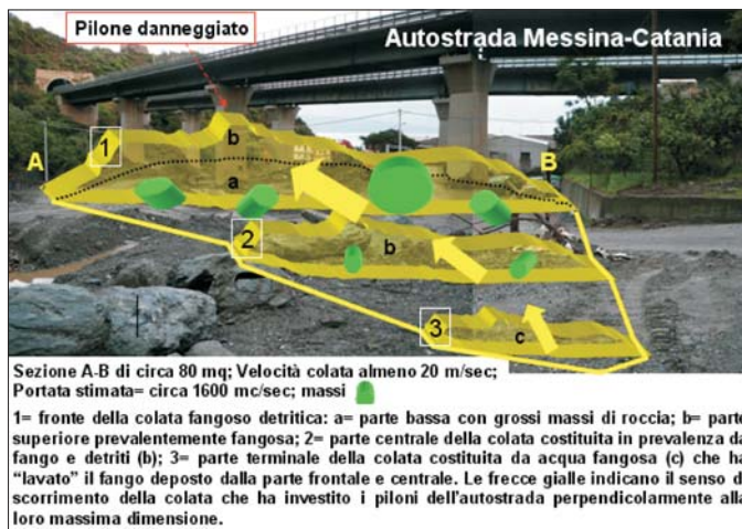
Figura 7 – Ricostruzione schematica della morfologia della colata fangoso-detritica nella zona d'impatto con i piloni dell'autostrada Messina-Catania eseguita sulla base delle tracce dei residui fangosi, dei detriti e degli effetti ambientali rinvenuti sul posto direttamente da Ortolani e Spizzuco.
