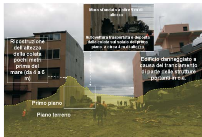
Figura 15 – Ricostruzione dell'altezza e della potenza della colata ed evidenziazione del notevole volume di fango deposto a poche decine di metri dalla spiaggia. Foto Zancle.it.
