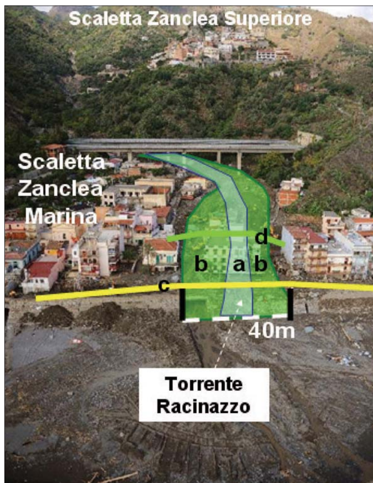
Figura 22 – Proposta schematica di messa in sicurezza dell'abitato di Scaletta Zanclea Marina. a= Nuovo alveo regimentato del T. Racinazzo; b= Alveo per lo smaltimento di eventuali flussi fangoso-detritici; c = Nuovo viadotto della linea ferroviaria; d= Nuovo viadotto della strada statale.
