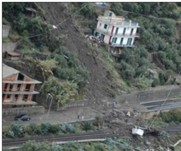
Figura 25 – Colata di fango innescatasi ed evoluta invadendo la strada statale e la linea ferroviaria, il 1° ottobre 2009, lungo il breve ma ripido versante incombente sul mare in corrispondenza di Capo Scaletta. Foto Vigili del Fuoco.
