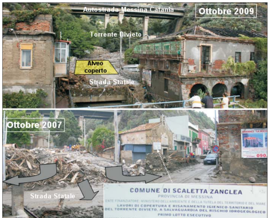
Figura 17 – La foto in alto illustra il tratto terminale del Torrente Divieto in corrispondenza del viadotto della strada statale e della copertura realizzata alcuni anni fa "a salvaguardia del rischio idrogeologico", come si evince dalla tabella relativa ai lavori durante l'alluvione dell'ottobre 2007 (foto in basso). Quest'ultimo evento provocò esondazione, trasporto e accumulo di fango, detriti e alberi sulla sede stradale che danneggiarono numerose abitazioni. Foto Zancle.it.
