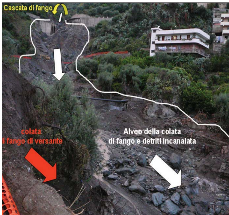
Figura 5 – Parte terminale del T. Racinazzo, a monte del viadotto dell'Autostrada, dove il flusso ha originato una cascata di fango (per effetto del salto altimetrico dovuto all'opera di sostegno a monte della strada) e inglobato massi di roccia di dimensioni variabili da qualche decimetro cubo a oltre 20 metri cubi.
