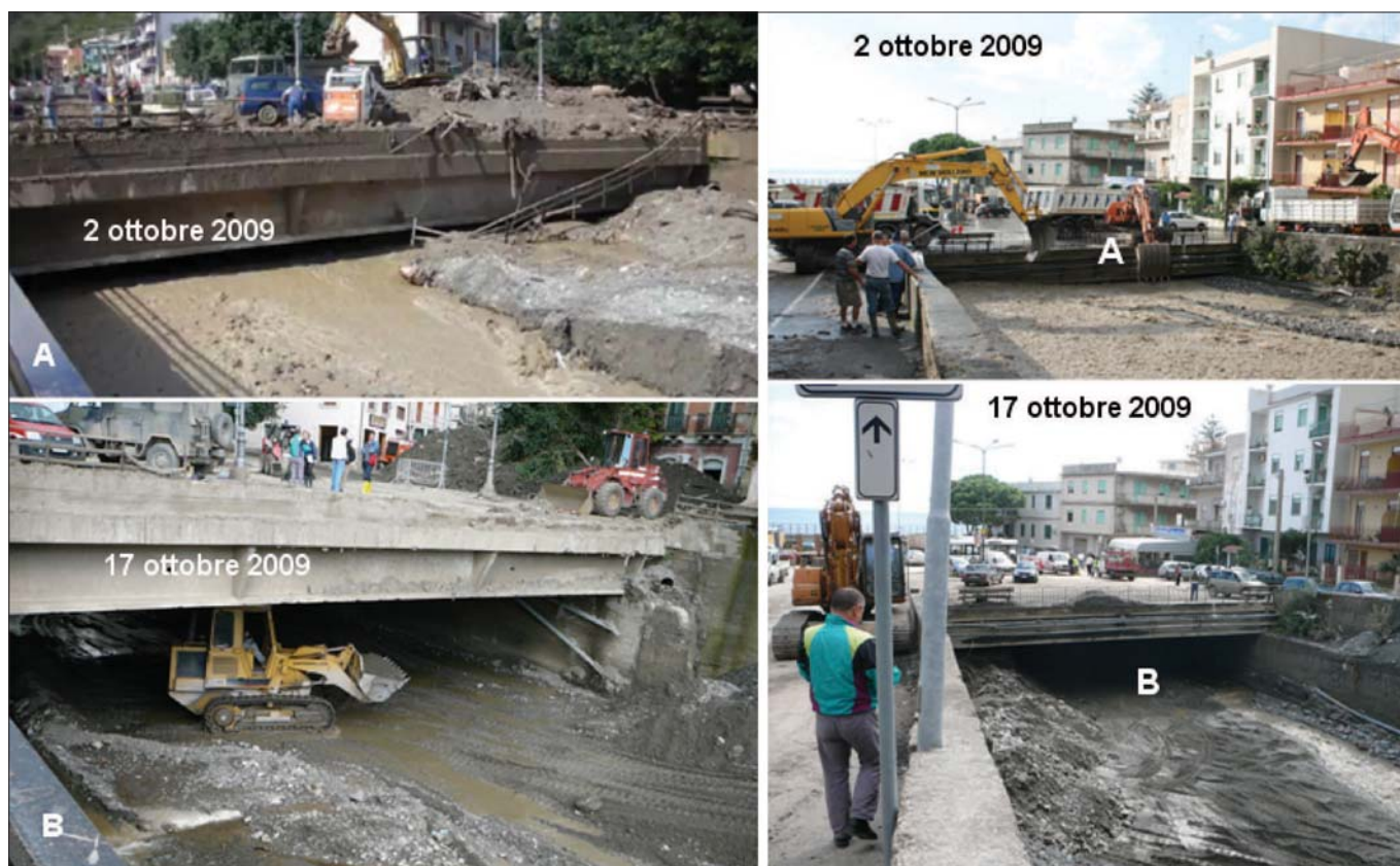
Figura 26 – A sinistra alveo della Fiumara di Giampileri Superiore, a destra alveo del Torrente Itala completamente colmati di detriti (A) e dopo il ripristino della sezione torrentizia (B).
