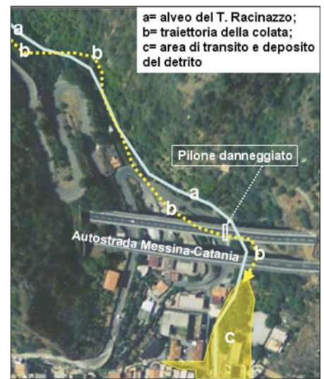
Figura 11 – Ricostruzione del tracciato, in base all'impronta lasciata lungo i versanti, del flusso fangoso-detrico nella parte terminale dell'alveo del Torrente Racinazzo (a). Sono evidenti le esondazioni del flusso (b) in corrispondenza delle anse del torrente che hanno provocato l'impatto del fronte della colata perpendicolarmente alla massima dimensione del pilone dell'Autostrada Messina-Catania. In giallo trasparente (c) è evidenziata l'area interessata dal transito e accumulo del detrito.
