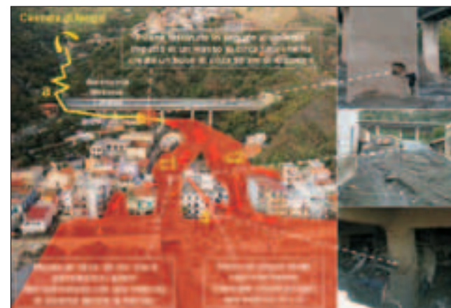
Figura 4: Ricostruzione schematica del percorso della colata fangoso-detritica nella parte terminale del Torrente Racinazzo a monte e a valle dell'Autostrada; l'area delimitata con il rosso trasparente è stata interessata dal transito della colata e da successivo accumulo di detriti. a= percorso della colata lungo l'alveo incassato dove ha effettuato varie curve paraboliche fino ad investire i piloni dell'Autostrada perpendicolarmente alla loro massima dimensione (b); c1 e c2 rispettivamente flusso destro e sinistro orografico nei quali si è suddivisa la colata che ha trascinato vari massi di roccia fino al mare che hanno tranciato parte delle strutture portanti in calcestruzzo armato di un palazzo (d). Le foto a destra rappresentano, dall'alto verso il basso, il buco nel pilone dell'Autostrada, il grande masso di circa 25 mc, un pilastro dell'edificio danneggiato dai massi inglobati nella colata.
