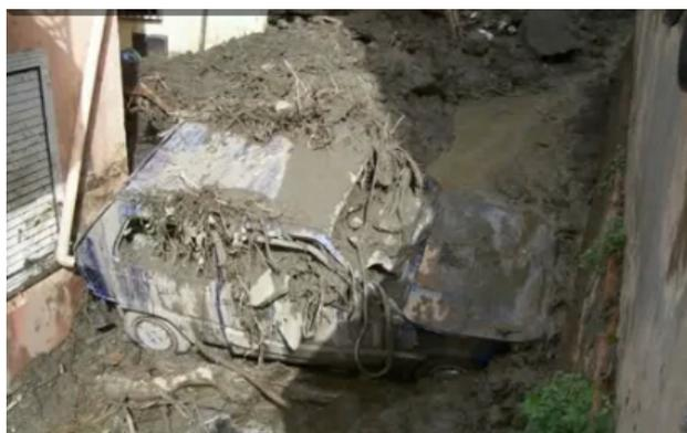
*Figura 34: Effetti distruttivi delle colate di fango incanalate nella parte alta degli alvei-strada (25 ottobre 2007). La foto in basso evidenzia l'effetto diga causato da un'autovettura incastratasi nella stretta strada e il conseguente accumulo di fango a monte.*
