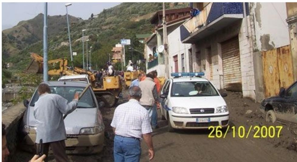
*Figura 35: Fango accumulato a valle dell'abitato a ridosso del Torrente Giampileri (25 ottobre 2007) proveniente dal bacino 1 (Torrente Loco-S. Anna). Effetti simili, più diffusi e più gravi, si sono verificati in seguito alle colate rapide dell'1 ottobre 2009 in tutta la parte bassa dell'abitato.*
