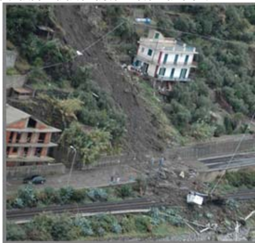
Figura 25: Colata di fango innescatasi ed evoluta invadendo la Strada Statale e la linea ferroviaria, il 1 Ottobre 2009, lungo il breve ma ripido versante incombente sul mare in corrispondenza di Capo Scaletta. Foto Vigili del Fuoco.
