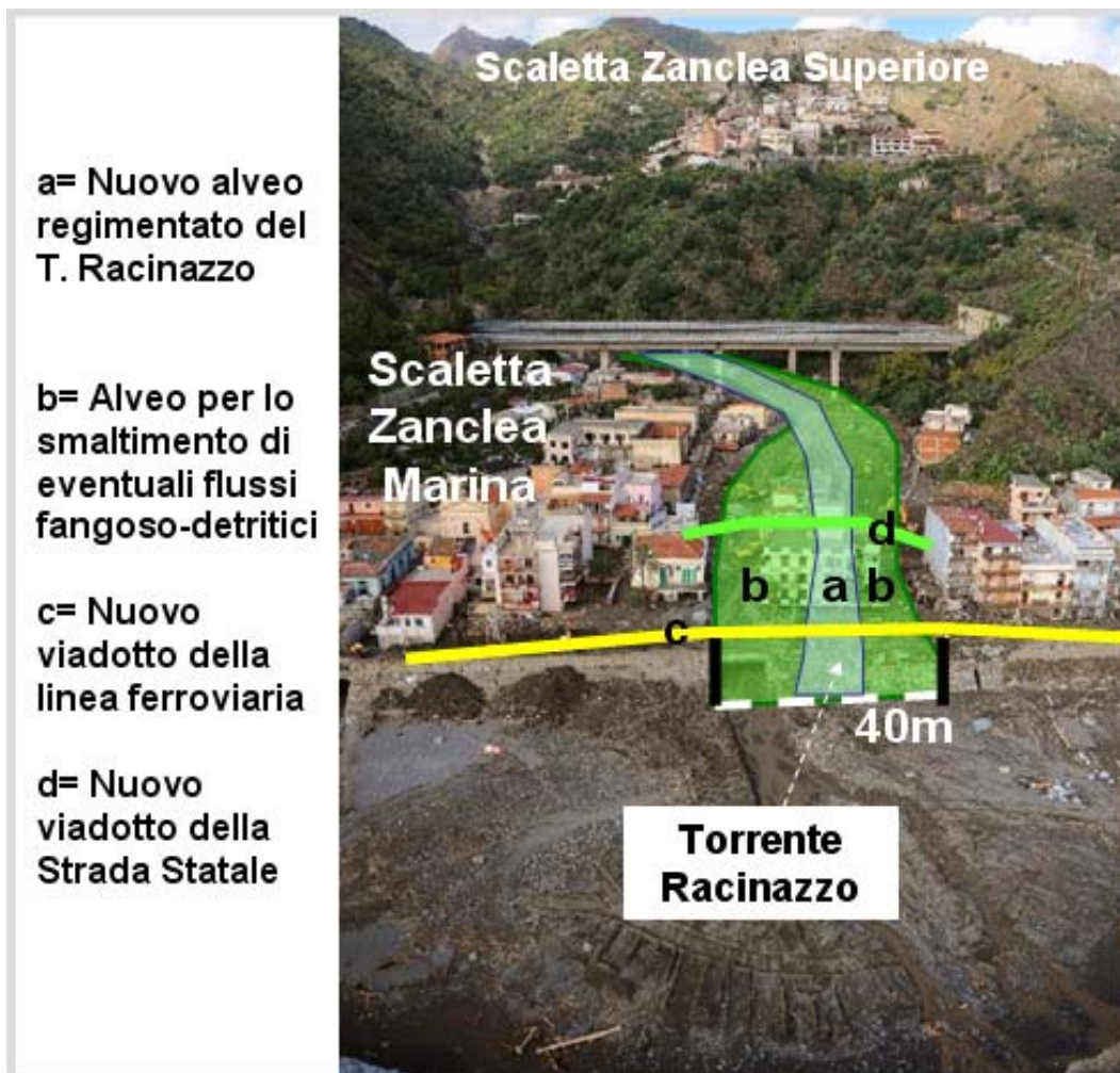
Figura 22: Proposta schematica di messa in sicurezza dell'abitato di Scaletta Zanclea Marina.
