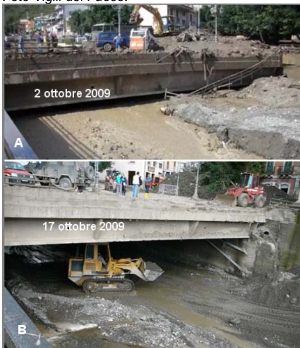
Figura 26: A sinistra alveo della Fiumara di Giampileri Superiore, a destra alveo del Torrente Itala completamente colmati di detriti (A) e dopo il ripristino della sezione torrentizia (B).
