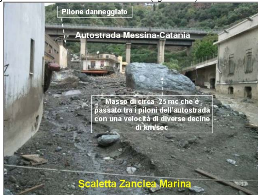
Figura 10: Massi di roccia di grandi dimensioni, inglobati nella colata fangoso-detritica, che hanno colpito o sfiorato i piloni dell'autostrada. Il masso di maggiori dimensioni è di circa 25 mc.
