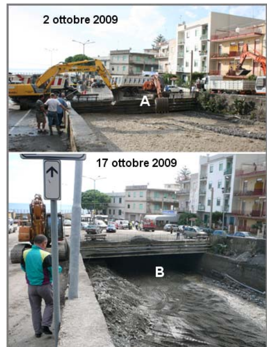
Figura 26: A sinistra alveo della Fiumara di Giampileri Superiore, a destra alveo del Torrente Itala completamente colmati di detriti (A) e dopo il ripristino della sezione torrentizia (B).
