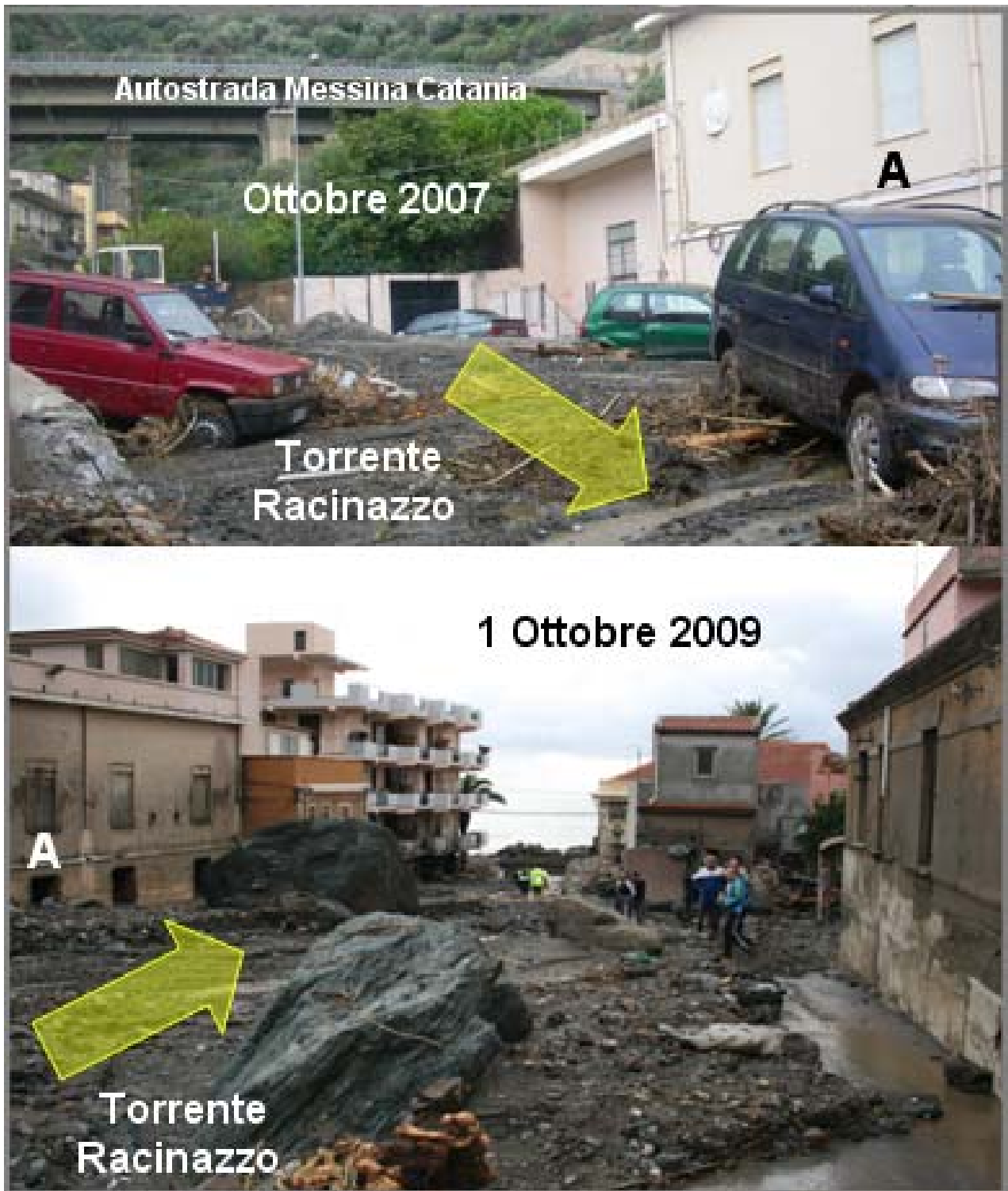
Figura 16: La foto in alto evidenzia l'impatto determinato dall'evento alluvionale dell'ottobre 2007, simile ma non così disastroso come l'evento del 1 ottobre 2009 (foto in basso), nell'area attraversata dall'alveo del T. Racinazzo dove è ubicato l'edificio indicato con la lettera A. Foto Zancle.it
