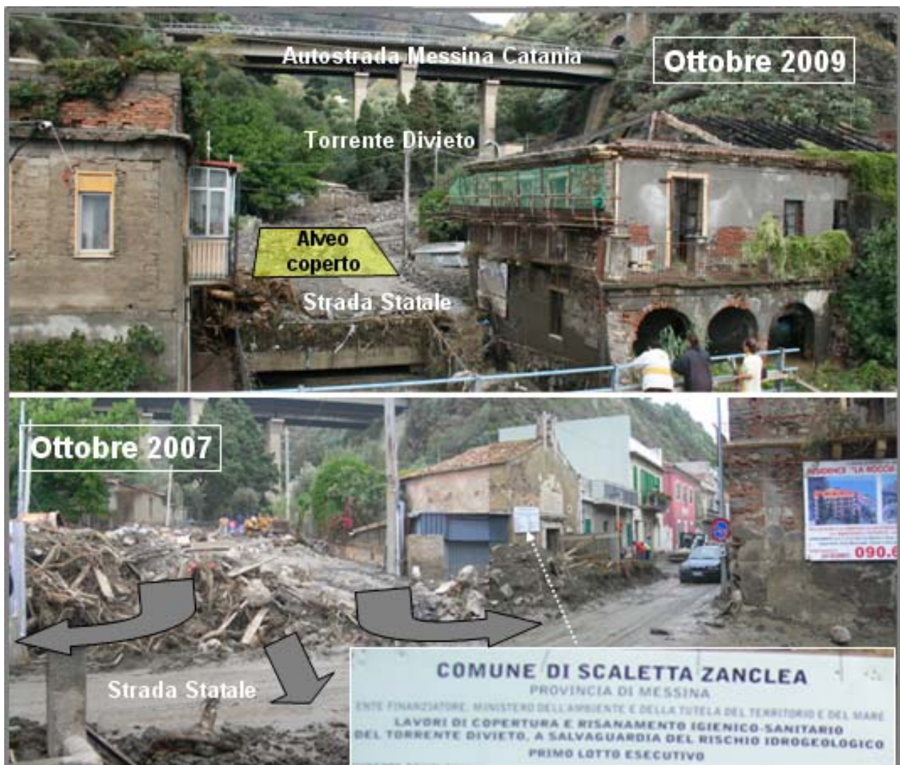
Figura 17: La foto in alto illustra il tratto terminale del Torrente Divieto in corrispondenza del viadotto della Strada Statale e della copertura realizzata alcuni anni fa "a salvaguardia del rischio idrogeologico" come si evince dalla tabella relativa ai lavori durante l'alluvione dell'ottobre 2007 (foto in basso). Quest'ultimo evento provocò esondazione e trasporto e accumulo di fango, detriti e alberi sulla sede stradale che danneggiarono numerose abitazioni. Foto Zancle.it
