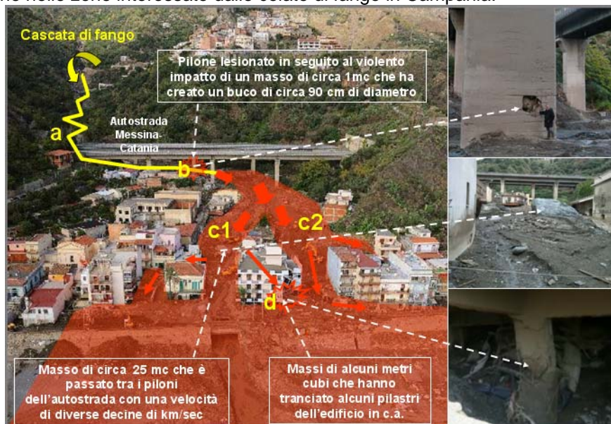
Figura 12: Ricostruzione schematica del percorso della colata fangoso-detrítica nella parte terminale del Torrente Racinazzo a monte e a valle dell'Autostrada; l'area delimitata con il rosso trasparente è stata interessata dal transito della colata e da successivo accumulo di detriti. a= percorso della colata lungo l'alveo incassato dove ha effettuato varie curve paraboliche fino ad investire i piloni dell'Autostrada perpendicolarmente alla loro massima dimensione (b); c1 e c2 rispettivamente flusso destro e sinistro orografico nei quali si è suddivisa la colata che ha trascinato vari massi di roccia fino al mare che hanno tranciato parte delle strutture portanti in calcestruzzo armato di un palazzo (d). Le foto a destra rappresentano, dall'alto verso il basso, il buco nel pilone dell'Autostrada, il grande masso di circa 25 mc, un pilastro dell'edificio danneggiato dai massi inglobati nella colata.
