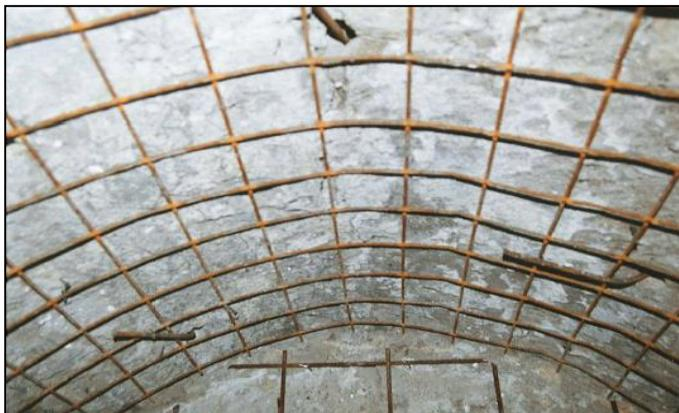
**Dettaglio dei connettori di fissaggio delle armature
