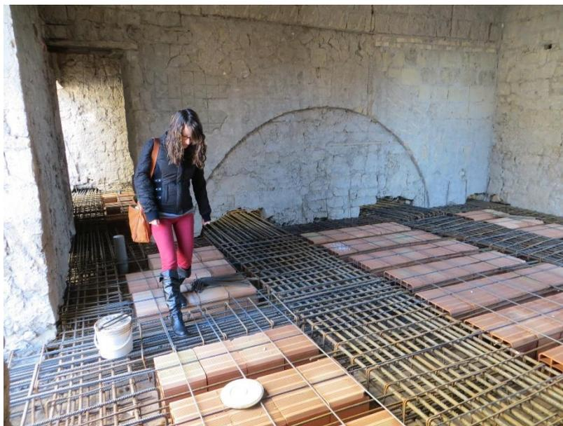
**Ulteriore vista del Solaio completo di pignatte ed
