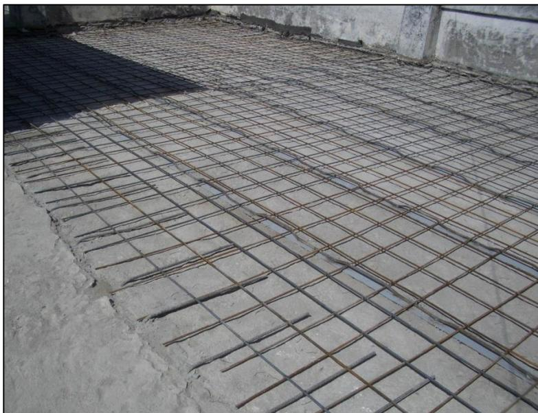
**Predisposizione delle barre d'armatura; visibili i ferri
