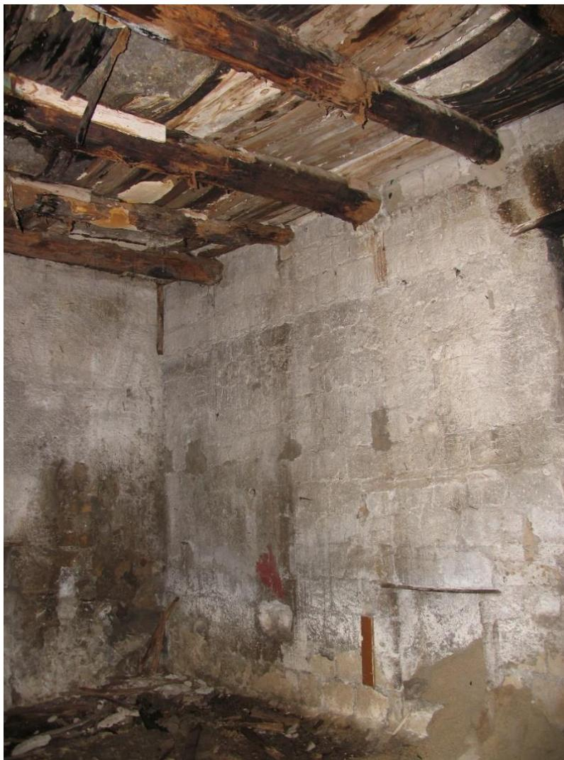
**Degrado di solaio in legno con travi di castagno
