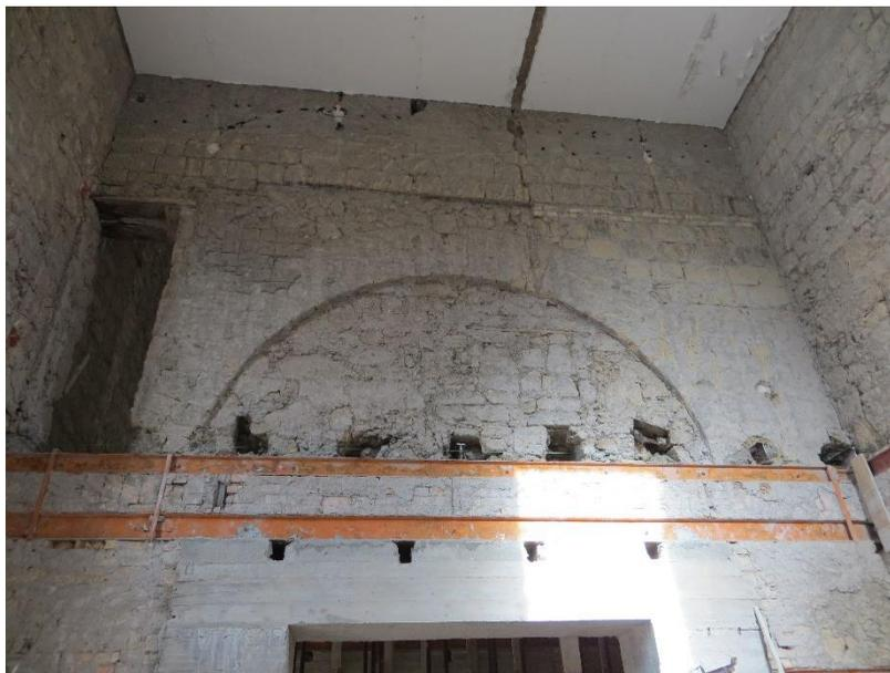
**Traccia d'imposta di un solaio in ferro da sostituire con
