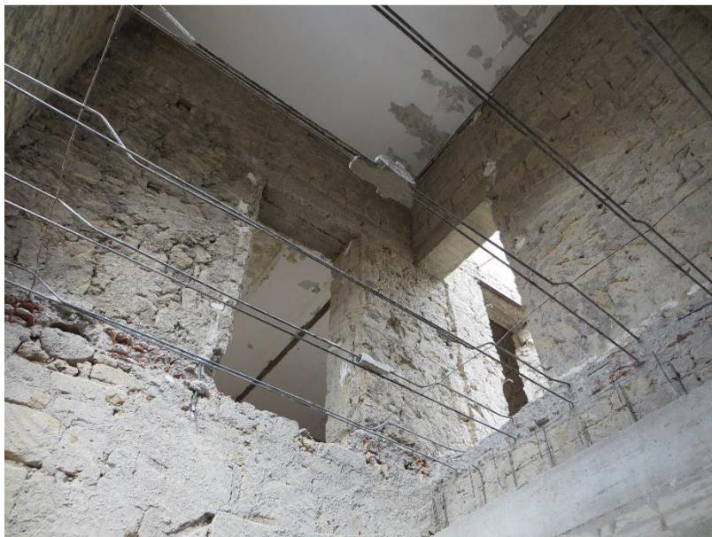
**Residui ferri d'armatura di un solaio demolito
