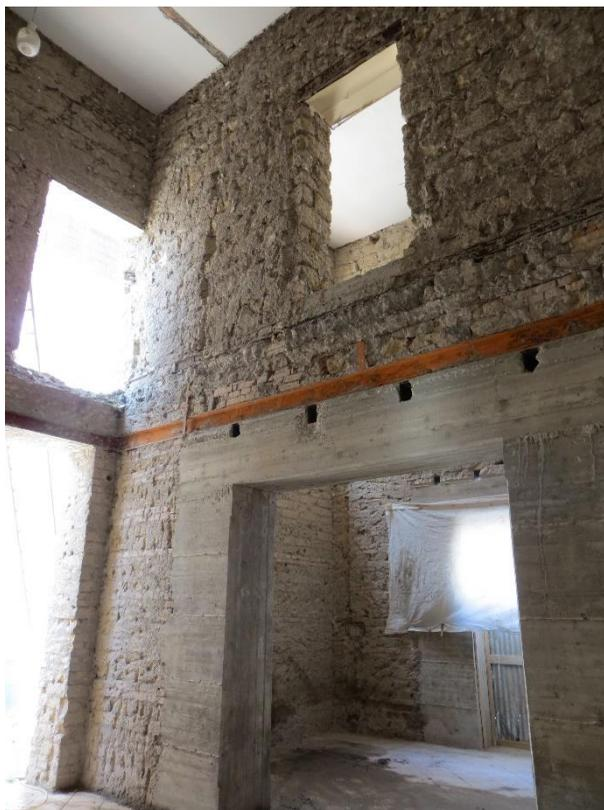
**Traccia d'imposta di un solaio demolito da sostituire con
